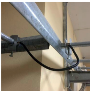
Seriejordning är tillåten vid funktionsutjämning av kabelstege.
